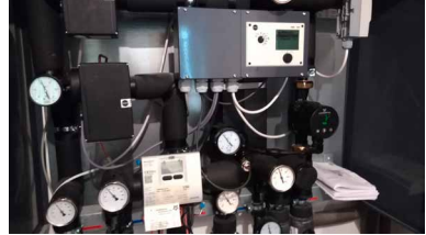
LSW-Fernwärmestation neu
